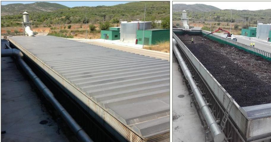
El biofiltro actúa como un **sistema biológico de depuración de gases**.
